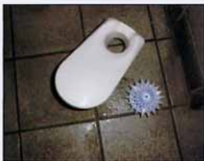
酵素阻害系尿石防止剤 ビビダリア ダリア専用目皿 ビビキャッチを設置
