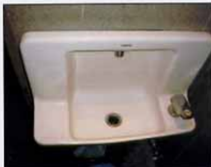
水垢により、美観を損ねている
