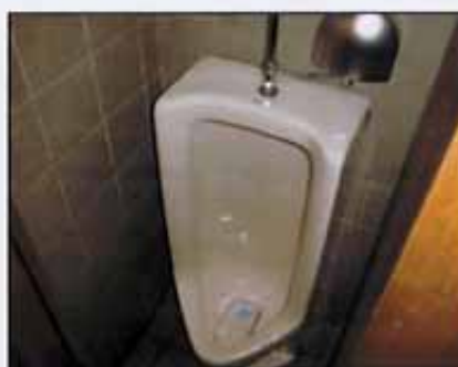
設置後、小便器全景
