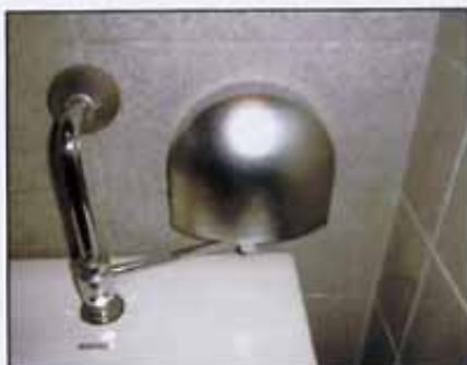
ダスキン酸系尿石防止剤を使用しているが尿石が多量に固着しており、効果がなく、経費の無駄になっている
